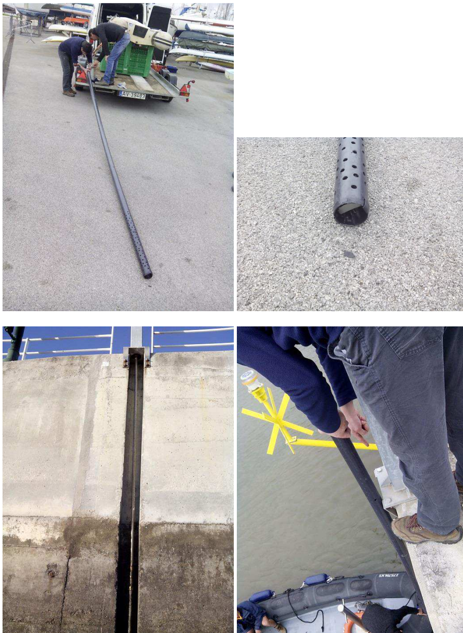
Figure 2.3 – Installation of the probe in the Marina Parque das Nações
